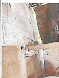
Foto 5: Muros perimetrales de las instalaciones de la cocina agrietadas, separadas de la pared contigua.
