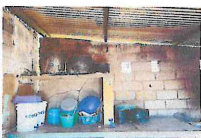
Foto 5: Muros perimetrales de las instalaciones de la cocina agrietadas, separadas de la pared contigua.
